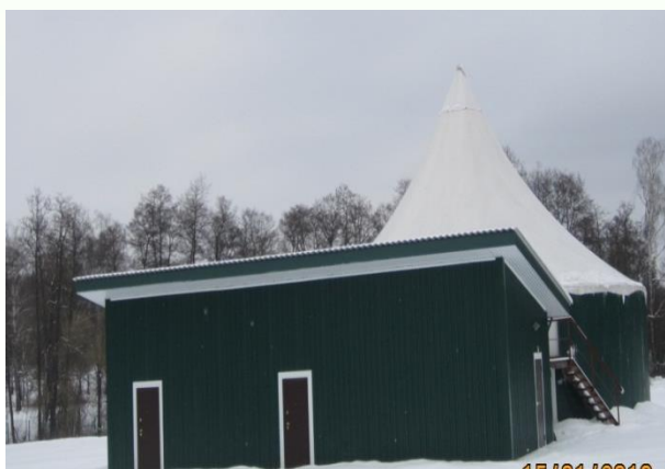
Очистные сооружения хозяйственно-бытовых стоков
