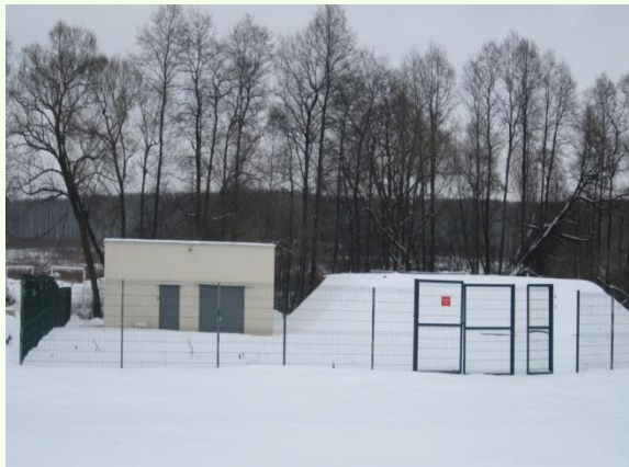
Территория водозаборного узла
